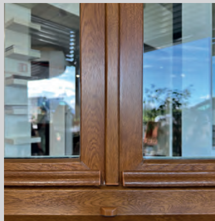
Battement central fin largeur 116mm
