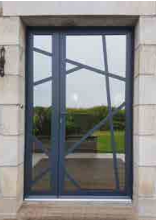
HYPE PORTE ALU TIERCÉE (tierce ouvrante) VITRAGE ANTELIO CLAIR REFLECHISSANT PLAT COLLES 30MM ALU EN APPLIQUE SUR LE VITRAGE
